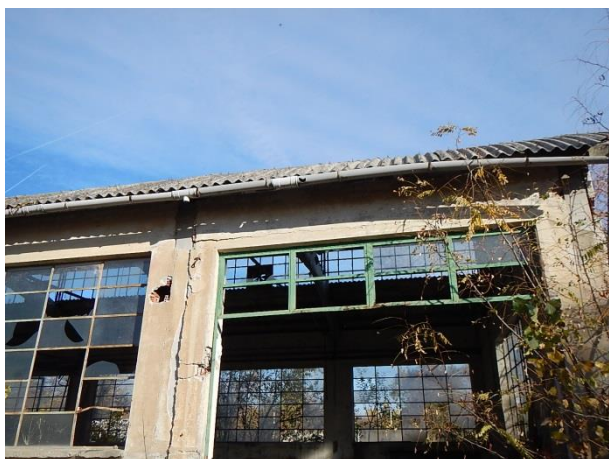
Edificio 8 – tetto a botte con oduline in fibrocemento
