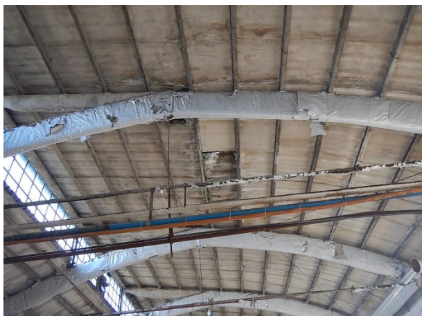
Edificio 8 – reparto filtrazione. archi portanti con isolante a spruzzo
