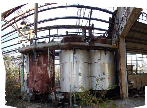
Area 12 – serbatoi con materiali isolanti contenenti amianto
