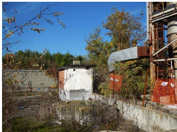
Edificio 15 – basso fabbricato con guaina bituminosa su copertura
