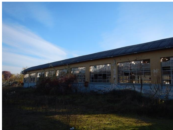
Edificio 5 – tettoia a singola falda con onduline in fibrocemento
