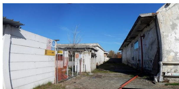
Foto 12 - Area “s” e “t” – magazzino in muratura. Guaina bituminosa su copertura
