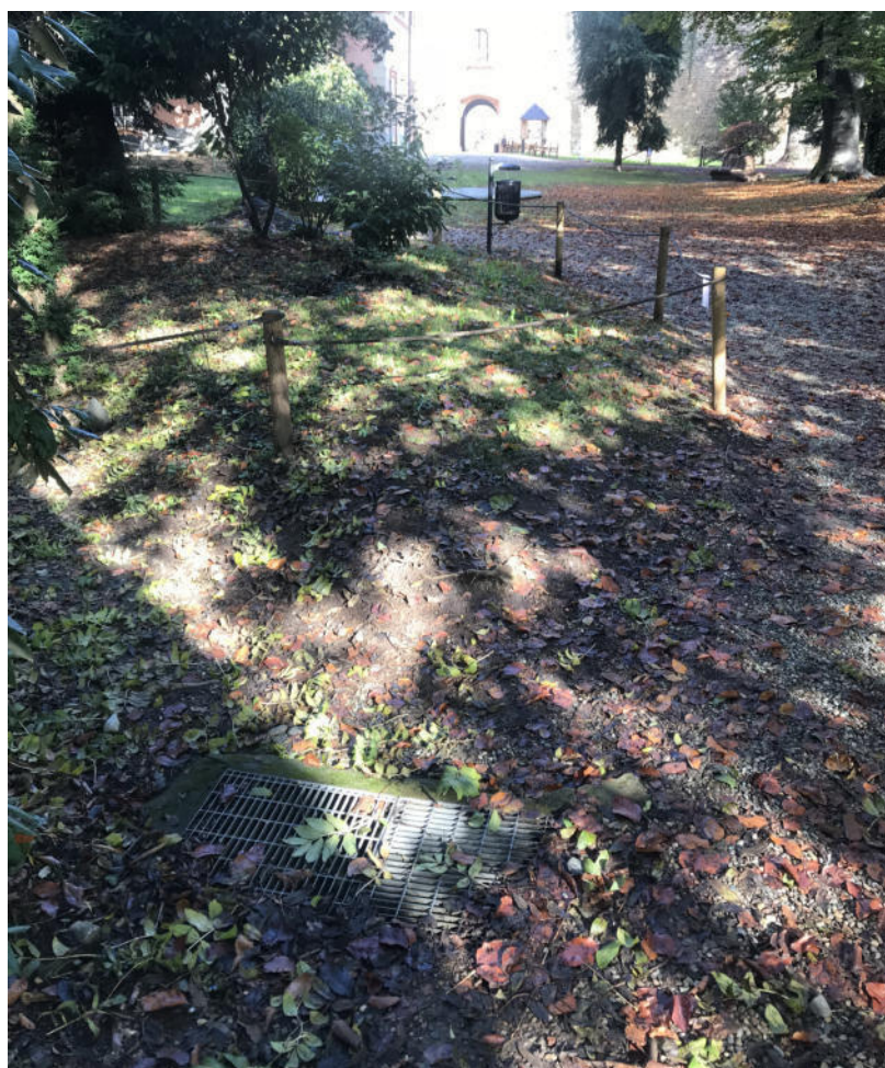
Foto n.4 – Vista generale con la caditoia di scarico delle acque della fontana
