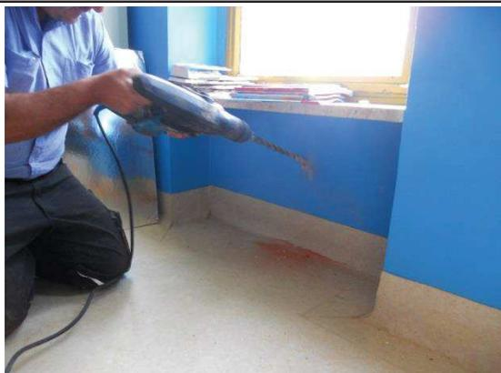
Foto 13 immagine relativa alle forometrie della parete sottofinestra
