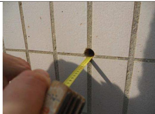
Foto 12 dettaglio della forometria dall'esterno della parete di tamponamento
