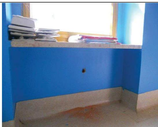
Foto 16 l'assenza di isolamento interno e lo spessore ridotto determina dei valori di trasmittanza termica elevati
